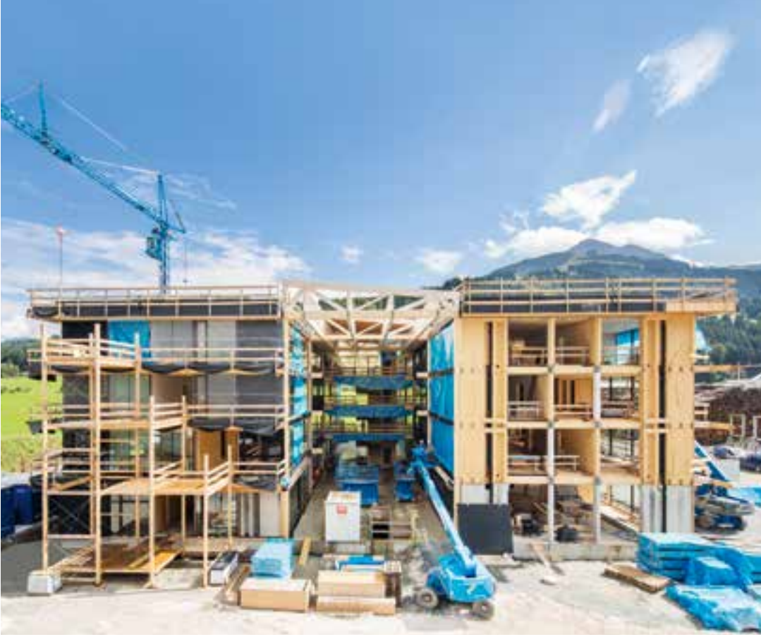
Yapı aşamasında olan St. Johann in Tirol (AT)'deki merkez yapı: Kendi malzemelerimizden yapılan yönetim binası, 2015 ilkbaharından bu yana 250'yi aşkın çalışanımıza ait bir mekan.
